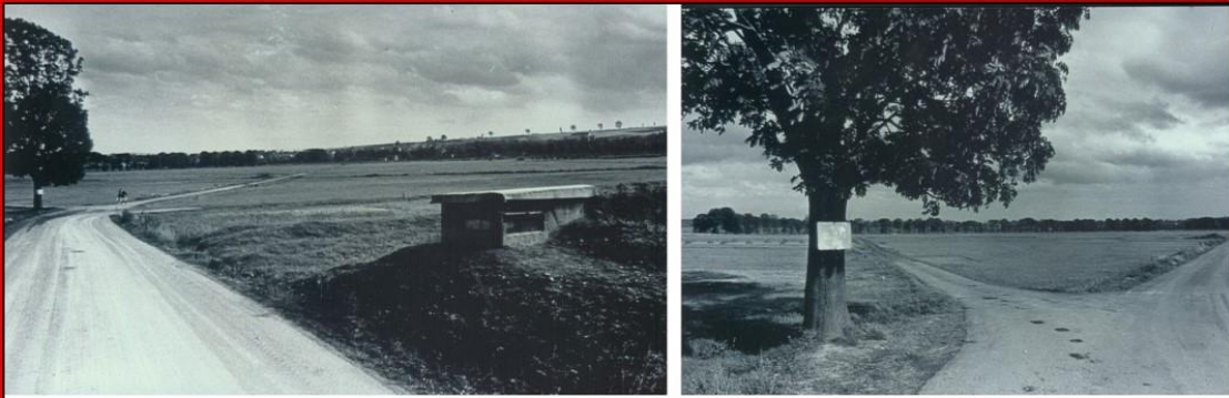
1960er Jahre: Blick von der Obersuhler Aue in Richtung Berkaer-Allee – Berka/Werra. Im Bild links ein Erdbeobachtungsstand, vermutlich Außenposten vom US-Stützpunkt OP ROMEO bei Bosserode.. Im Bild links ist am Baum ein Grenzhinweisschild angebracht.
