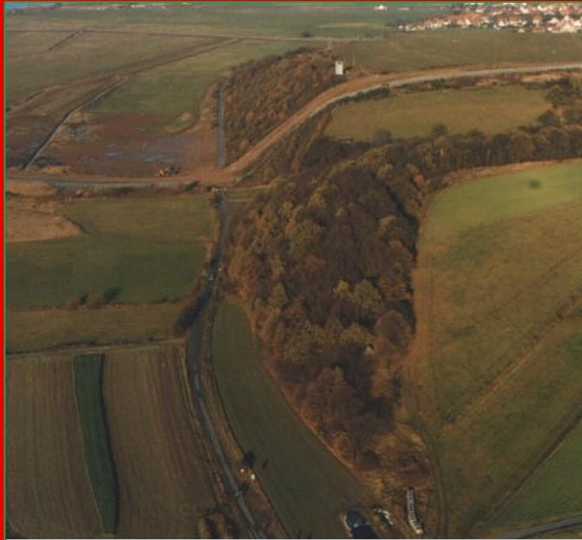
Dezember 1989: Straßenbauarbeiten Leimbach (Hessen) und Dippach (Thüringen). Die offizielle Grenzöffnung fand am 22.12.1989 um 14.00 Uhr statt.
