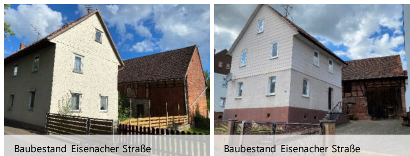
Abbildung 36: Baustruktur und Siedlungsbild im Ortskern Obersuhl
