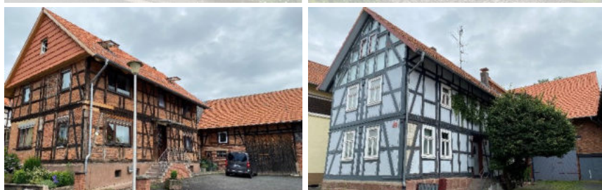
Hofreite Dankmarshäuser Str.
