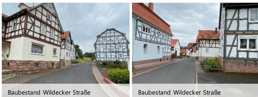
Abbildung 41: Baustruktur und Siedlungsbild im Ortskern Raßdorf
