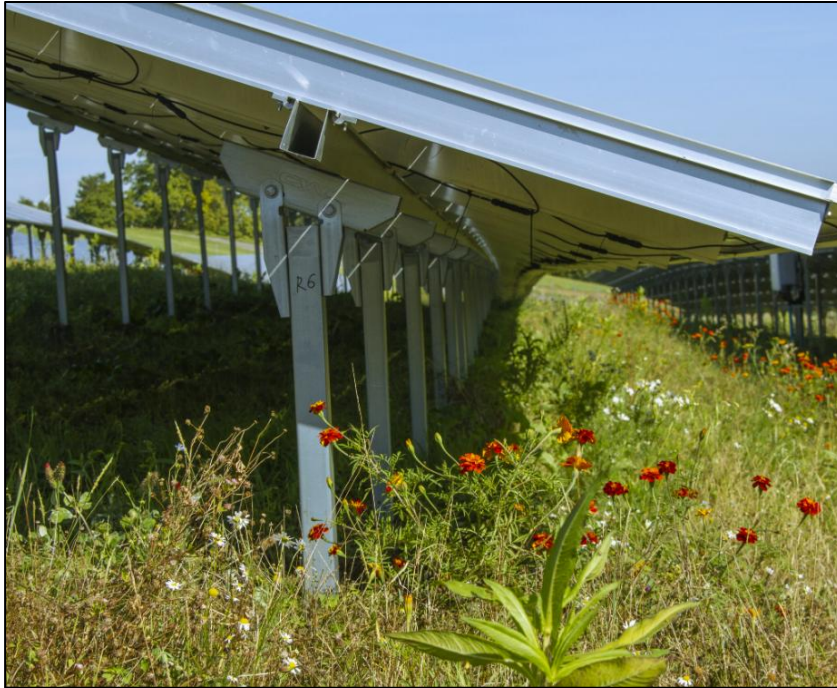
Ausschnitt Referenzen CWF GmbH – eingerammte Pfosten in Boden
